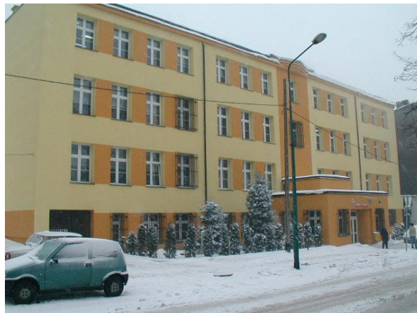
Budynek szkoły po remoncie – zima 2004
